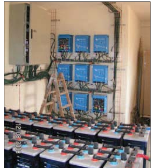
Postavljanje sustava s devet bidirekcijskih izmjenjivača u španjolskom Toledu.
