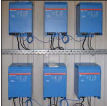
LIJEVO: Fotonaponsko otočno postrojenje namijenjeno potrebama prerade na poljoprivrednom imanju. Instalacije, kontrolni uređaji, baterije i šest bidirekcijskih pretvarača smješteno je u jedan manji brodski kontejner.
