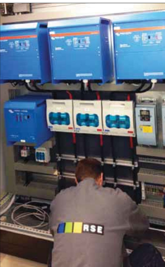
Slika 11. Detalji izgradnje sustava. Razdjelnik s učinkom elektronikom, baterijska banka, mrežni izmjenjivači... (Schrack + RSE GmbH).
