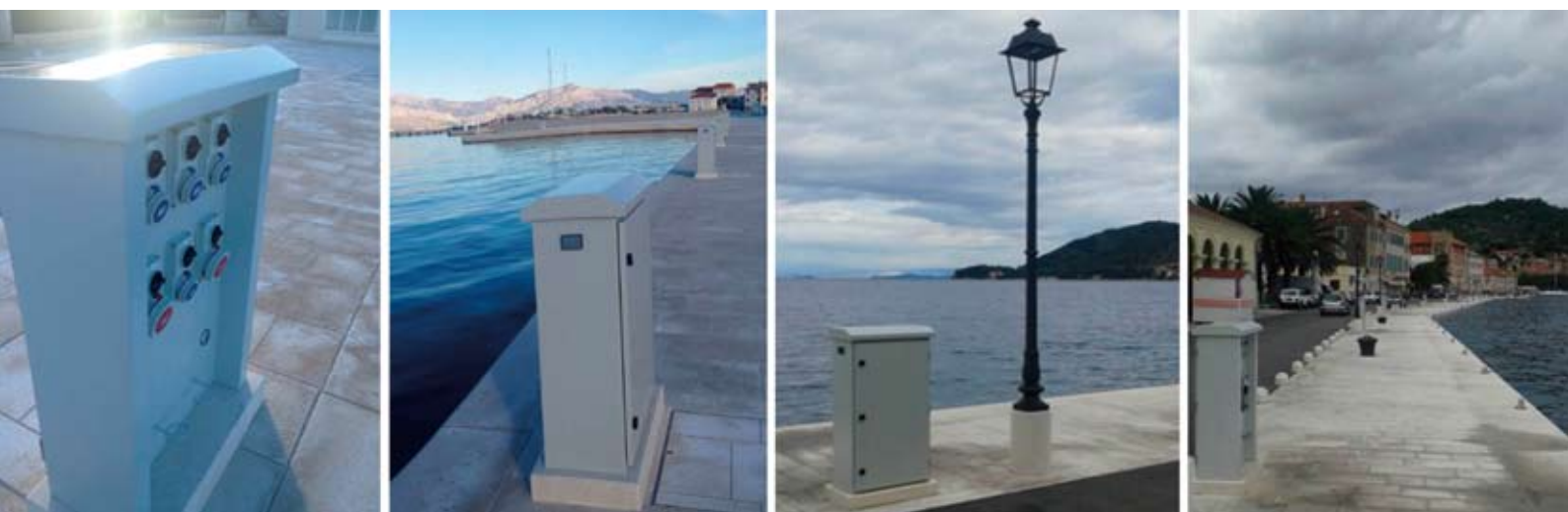
Slika 14. Priključni ormarići u luci Supetar na otoku Braču i u luci Vis na otoku Visu
