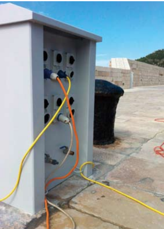
Slika 8. Priključni ormarići u Komizi s korisničke strane po danu i uvečer, po noći
