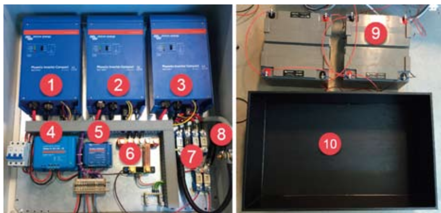
Slika 9. Sustav po završetku funkcionalnog ispitivanja
