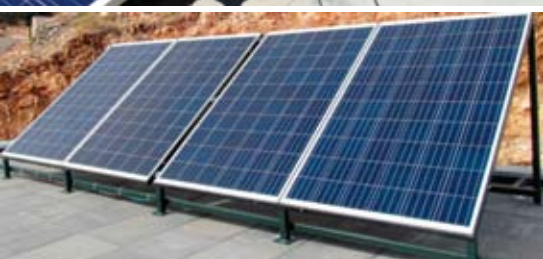
Slika 5 i 6. Probni spoj fotonaponskih modula u radionici (gore), spoj na ciljnom odredištu (dolje)
