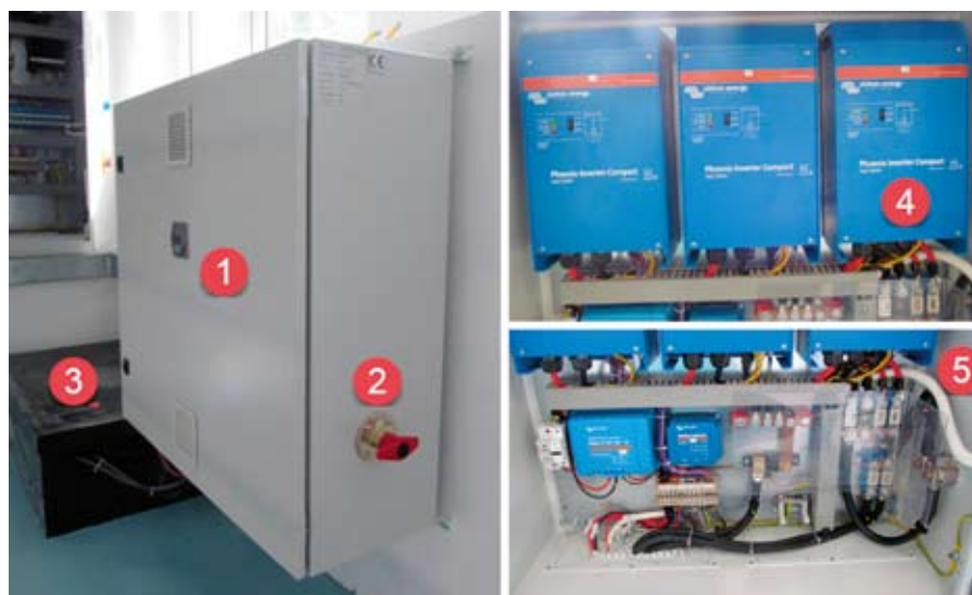
Slika 12. Oprema sa slike 9 montirana na odredištu
