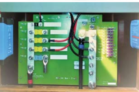
Slika 8.i 8a Neožičena i ožičena Victron ESP DC Link Box – kutija za razvod plus i minus pola baterije
