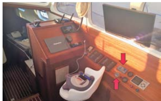
Slika 6. Smještaj nadzornika baterije BMV702 i Digital Multi control nadzornika
