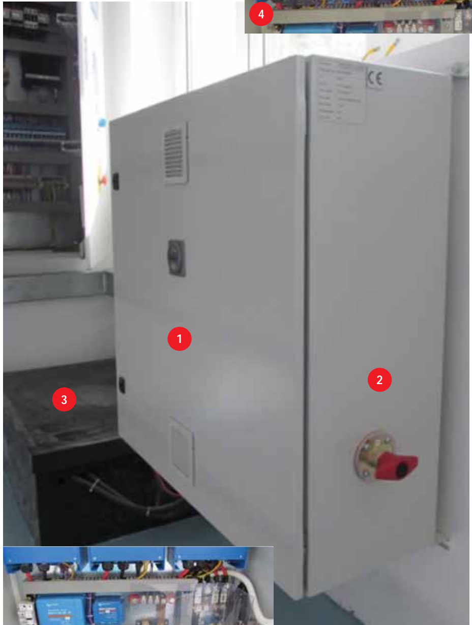
Slika 11 Oprema montirana na odredištu.
