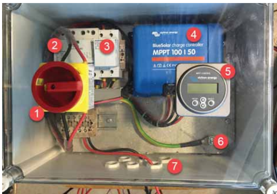
Slika 6 Razvodni ormarić između modula i baterija u radionici i na objektu.
