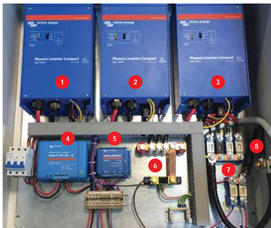
Slika 7 Ispitivanje funkcionalnosti tri autonomna izmjenjivača.
