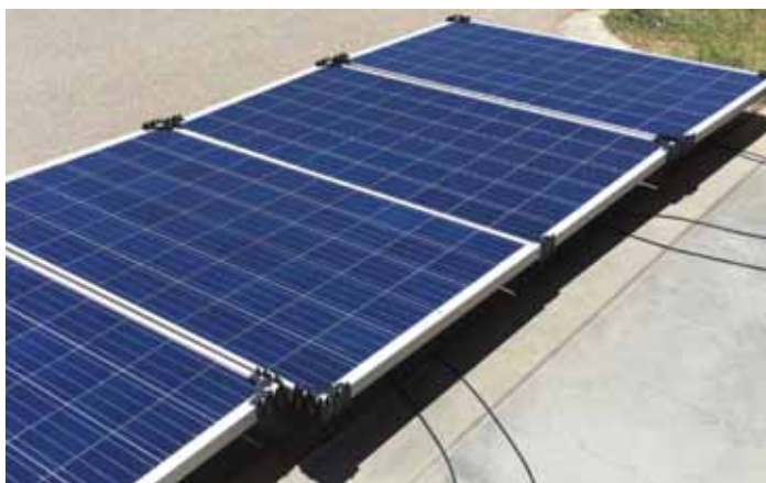
Slika 5 Probni spoj fotonaponskih modula u radionici (lijevo) i spoj na ciljnom odredištu (desno).
