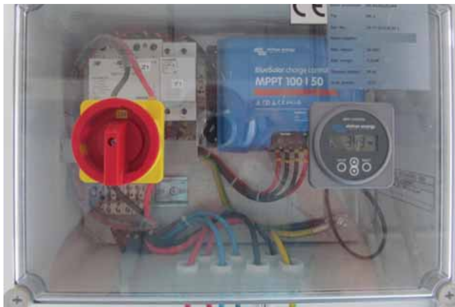
Slika 6 Razvodni ormarić između modula i baterija u radionici i na objektu.
