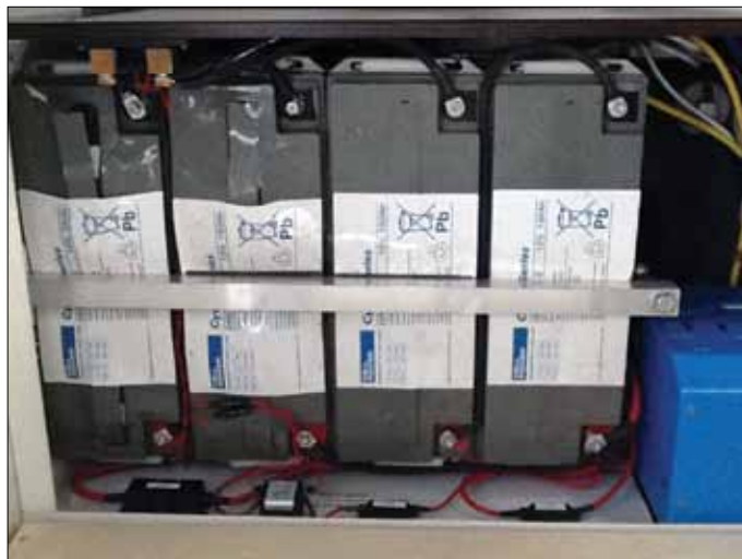
Slika 5.: Termički pobjeg zatvorenih baterija. Posuda baterije je deformirana zbog pregrijavanja i unutrašnjeg tlaka plinova.
